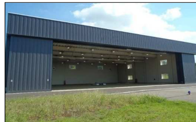
大島空港格納庫
