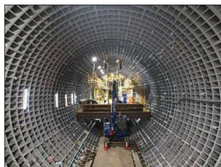
構築されたトンネル内(鋼製セグメント) (令和5年5月31日)
