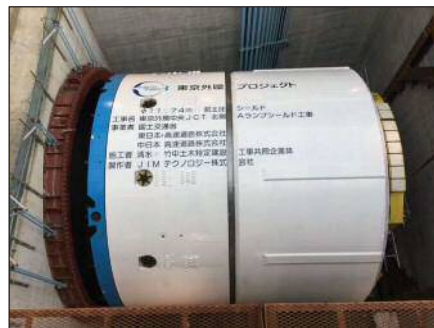
シールドマシンの組立完了状況 (平成30年2月8日)
