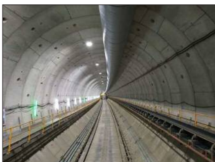
構築されたトンネル内(鉄筋コンクリートセグメント) (令和5年3月28日)
