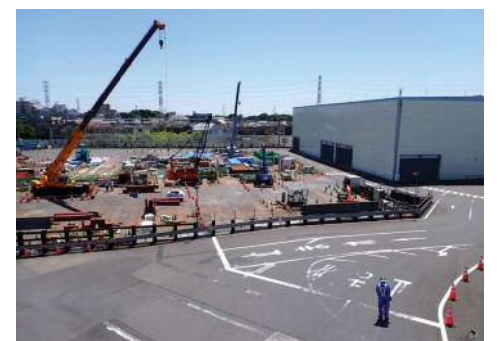
中央JCT南側開削トンネル施工状況 (令和5年4月27日)
