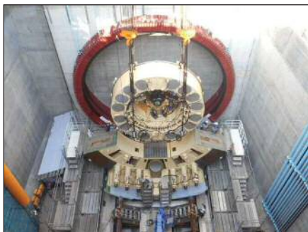
シールドマシンの組立状況 (平成29年10月27日)
