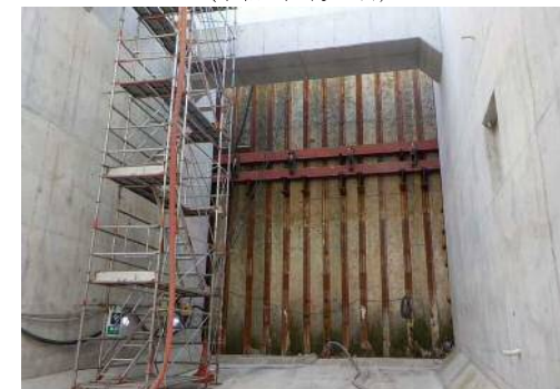
中央JCT北側開削トンネル施工状況 (令和5年2月1日)
