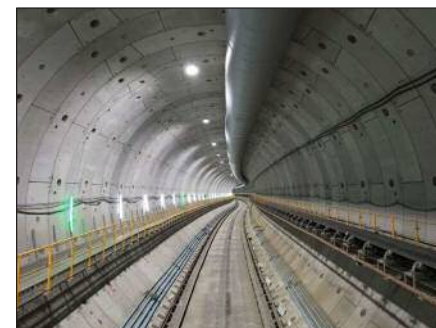
構築されたトンネル内(合成コンクリートセグメント) (令和5年3月28日)
