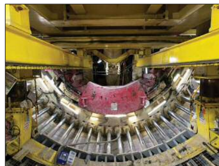
シールドマシンによる掘進状況 (令和5年3月23日)
