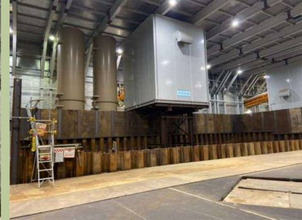
Bランプ土砂ピット (令和4年11月17日)
