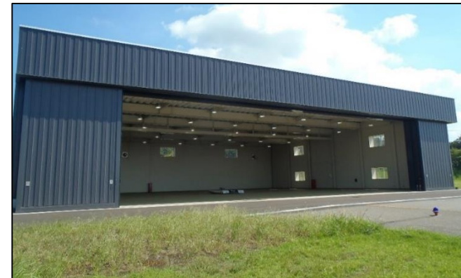
大島空港格納庫
