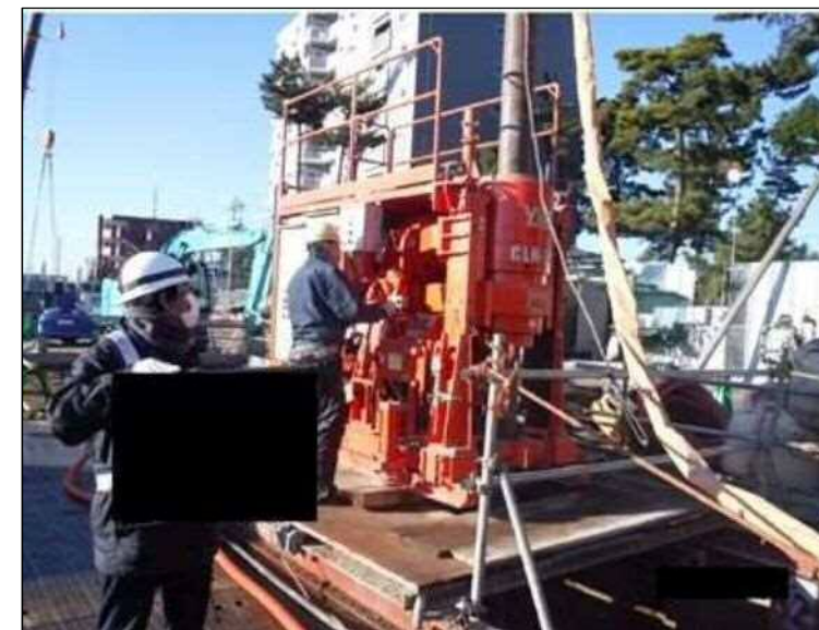
樹木近傍での施工状況
