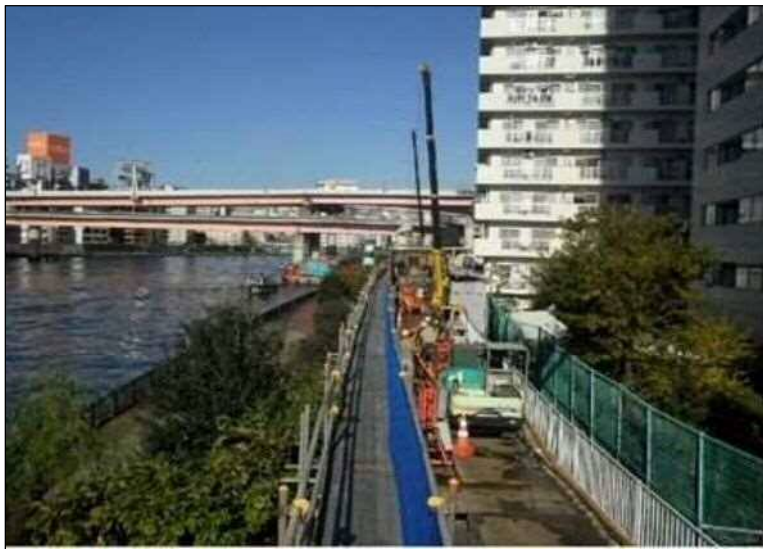
市街地での施工状況
