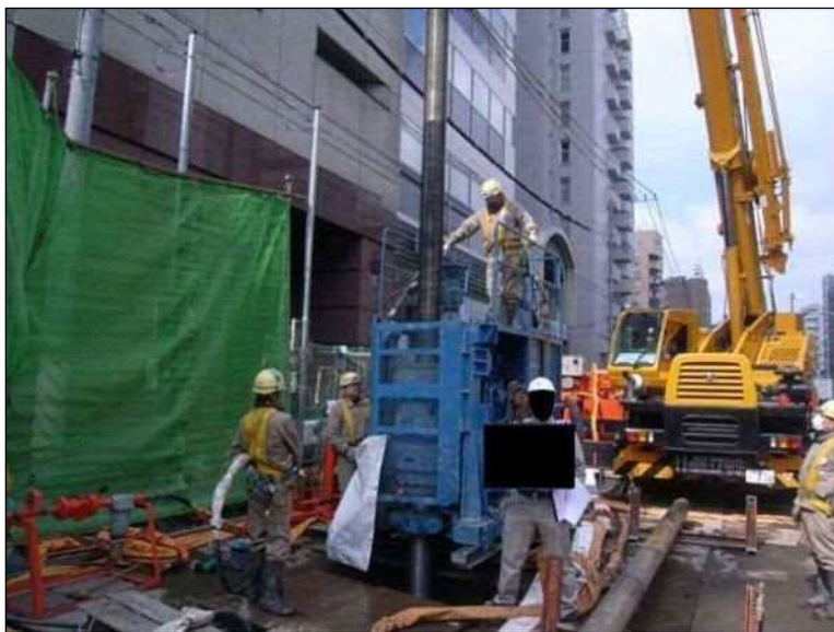
市街地での施工状況
