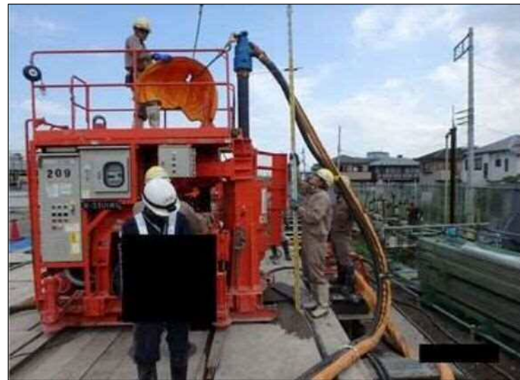
住宅地での施工状況
