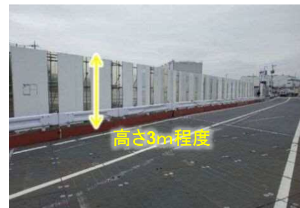
①防音タイプの仮囲い
