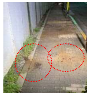
調布市道への鉄錆片の落下状況)
