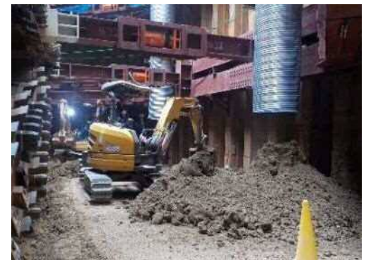
④開削範囲の埋め戻し
