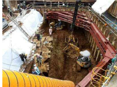
①地上からの開削作業
