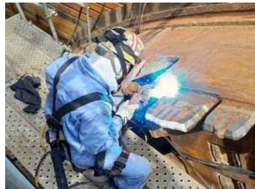
③カッタービット・攪拌翼等の補修
