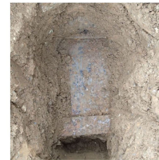
地中壁位置現地確認状況(測量)
