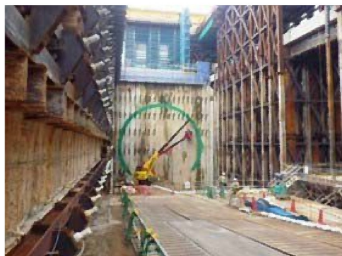
工事の写真(イメージ)
