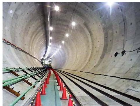
トンネル内部の写真(イメージ)
