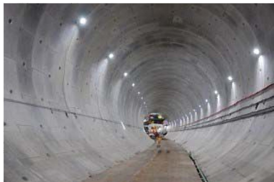
トンネル内部の写真(イメージ)
