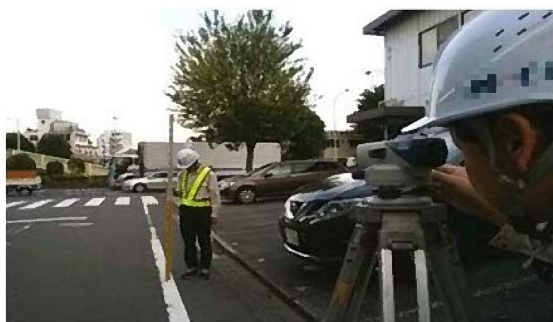
地上部での作業（イメージ）
