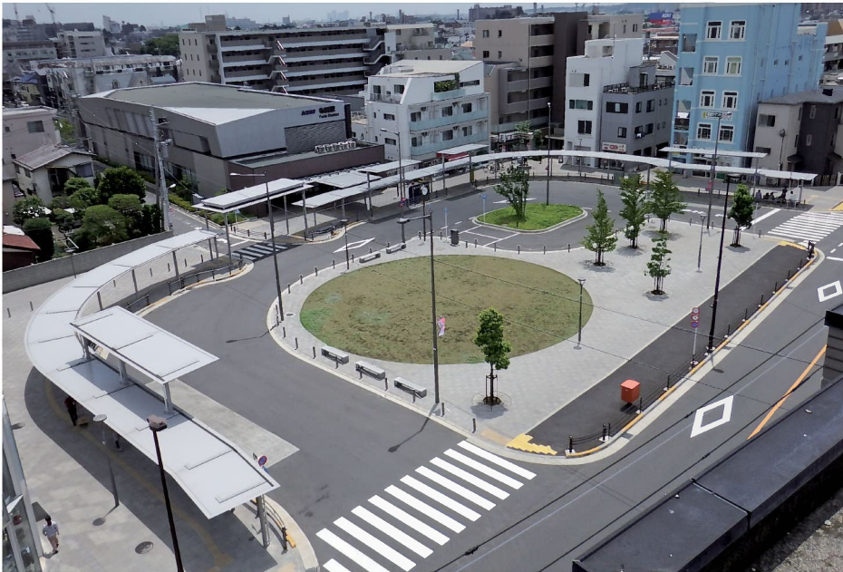
布田駅前広場を北西側から撮影
