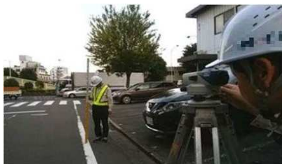
地上部での作業（イメージ）
