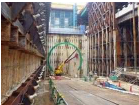
工事の写真(イメージ)
