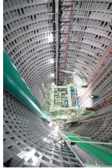
シールド坑内の状況 (2019年12月26日)
