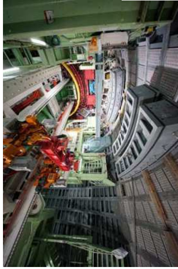
セグメント組立て状況写真 (2019年5月23日)
