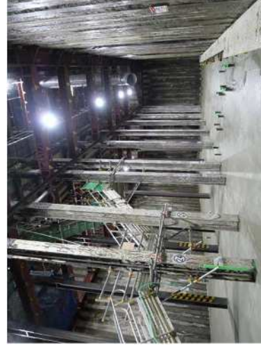
Hランブ箱体構築の状況（2020年1月7日）
