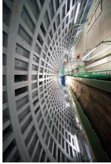
シールド機内の状況 (2019年6月25日)
