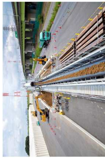
土砂仮置き場における、ベルトコンベアの終着点の様子（2019年9月18日）
