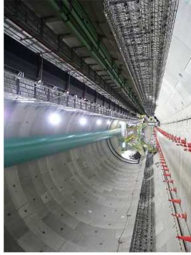
内部構築工・側壁鉄筋組立（2020年1月14日）
