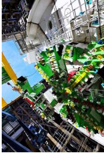
シールド機カッタ部の投入・組立を行っている状況（2018年4月27日）
