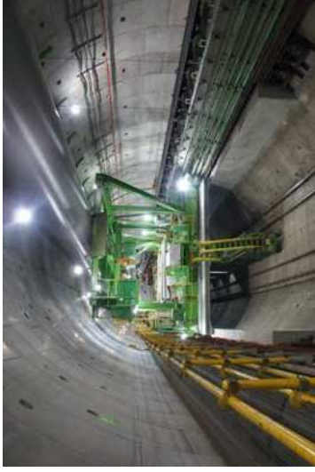
トンネル坑内の内部構築作業の状況 (2019年10月31日)
