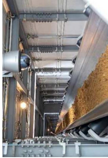
シールドマシンによって掘削した土砂を、ベルトコンベアに乗せて仮置き場へ搬送する様子（2019年9月18日）
