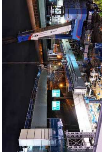
大泉南 開削部 路面覆工の設置を行っている状況 (2019年12月20日)
