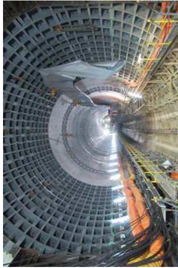
大泉南 開削部のFランプシールドの掘進を行っている状況(2020年1月7日)
