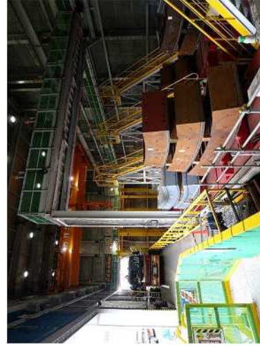
セグメントストックヤードのセグメント仮置状況（2020年1月7日）
