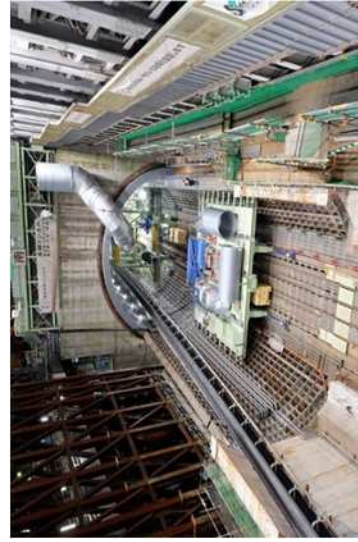
立坑状況写真 (2019年11月20日)
