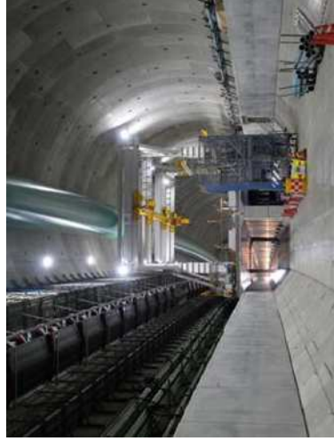
内部構築工・床版設置（2020年1月7日）
