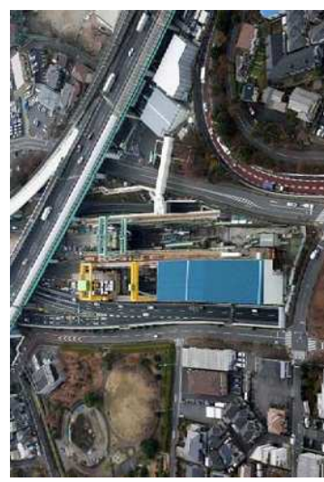
立坑全景写真 (2019年12月26日)
