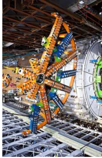
大泉JCT北行シールドマシンの組立状況 (2018年6月22日)
