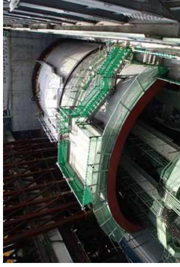
シールド機組立完了状況 (2019年1月27日)
