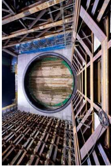
発進立坑部の坑口及び発進受台の設置が完了し、これからシールド機の組立を開始する状況（2018年3月15日）
