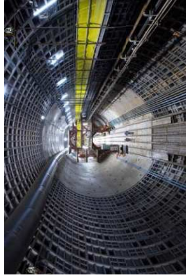
シールド工事の進捗により、構築されたトンネル坑内の様子（2019年9月18日）
