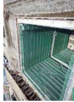
ケーソン構造部施工状況①
