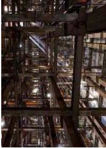
支保工・覆工板施工状況
