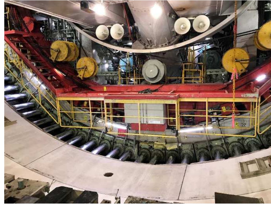
写真2 坑内状況写真(マシン下部)
