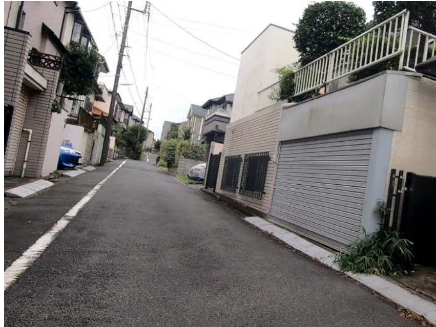
写真1 陥没箇所の事前状況写真(2020年7月30日)
