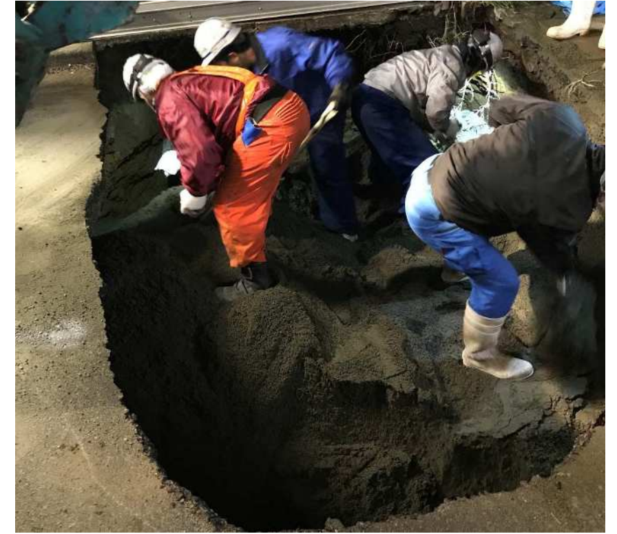
写真3 陥没箇所の応急復旧対応状況(埋戻し)
