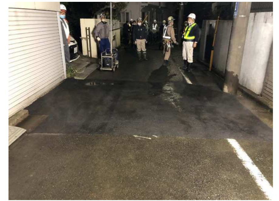
写真6 陥没箇所の応急復旧対応状況(舗装完了)
