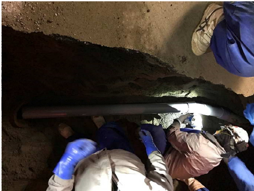
写真4 住宅下水管復旧状況
