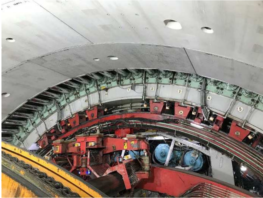
写真1 坑内状況写真(マシン上部)
