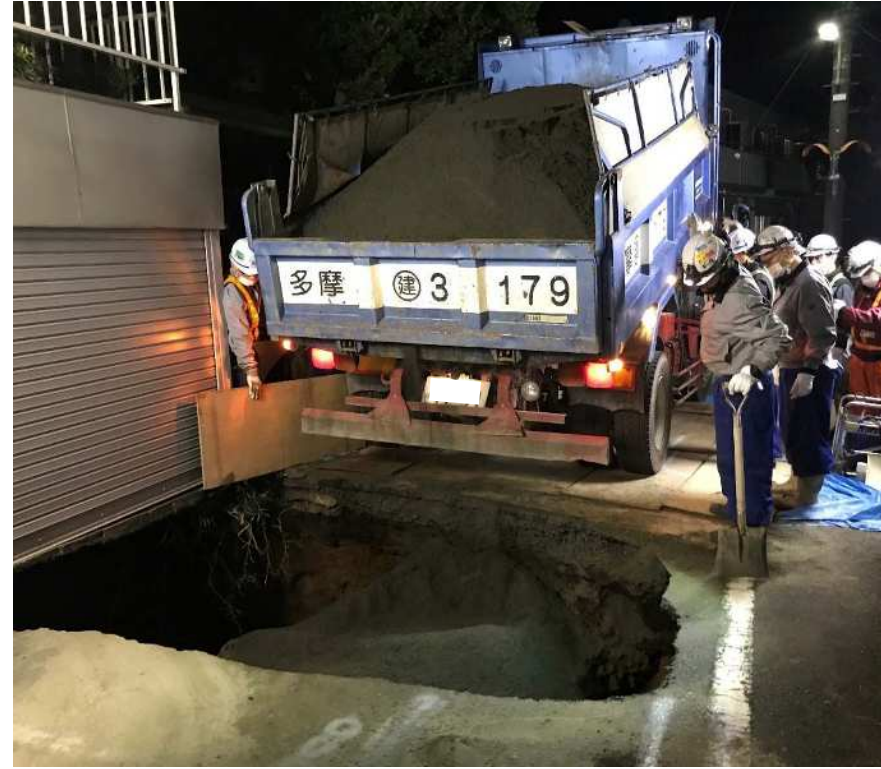
写真2 陥没箇所の応急復旧対応状況(埋戻し)
