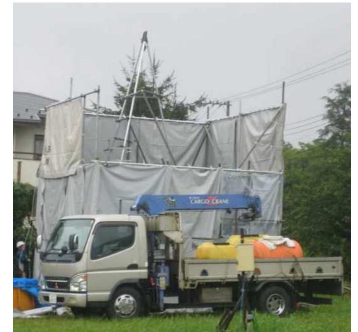
ボーリング調査イメージ
