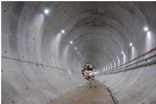
トンネル内部の写真(イメージ)
