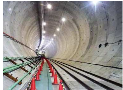
トンネル内部の写真(イメージ)
