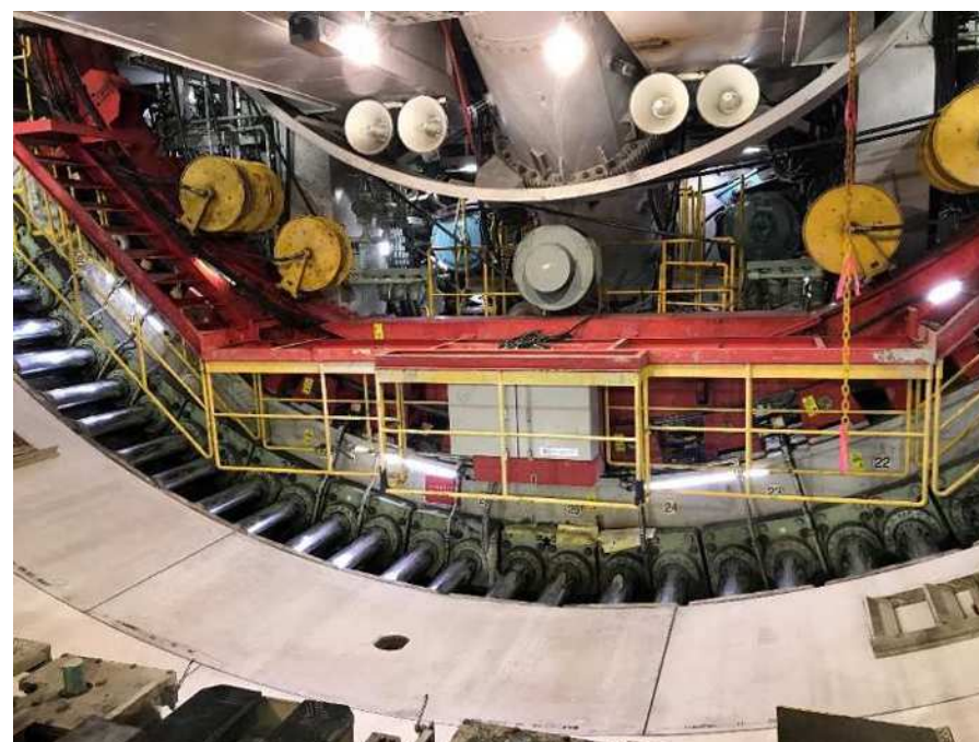
写真2 坑内状況写真(マシン下部)
