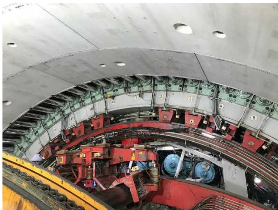
写真1 坑内状況写真(マシン上部)
