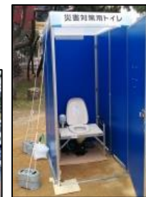
▲マンホールトイレ設置状況（内観）
