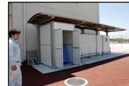
▲マンホールトイレ展開後
