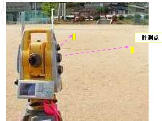
自動測量イメージ(トータルステーション)
