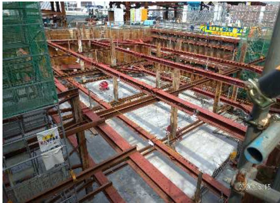
ランプ部開削ボックス施工状況(東名JCT)
