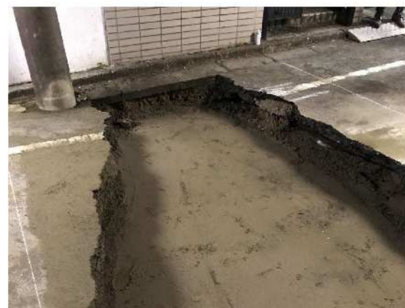
写真5 陥没箇所の応急復旧対応状況(埋戻し完了)
