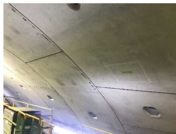
写真5 坑内状況写真(陥没位置付近セグメント状態)
