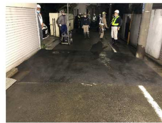
写真6 陥没箇所の応急復旧対応状況(舗装完了)
