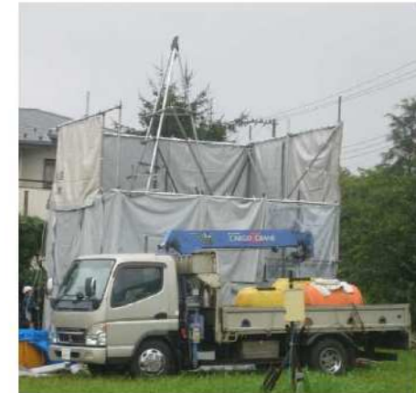
ボーリング調査イメージ
