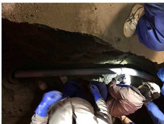
写真4 住宅下水管復旧状況
