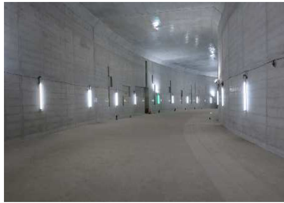
ランプ部開削ボックス施工状況(中央JCT)
