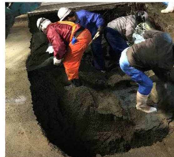
写真3 陥没箇所の応急復旧対応状況(埋戻し)
