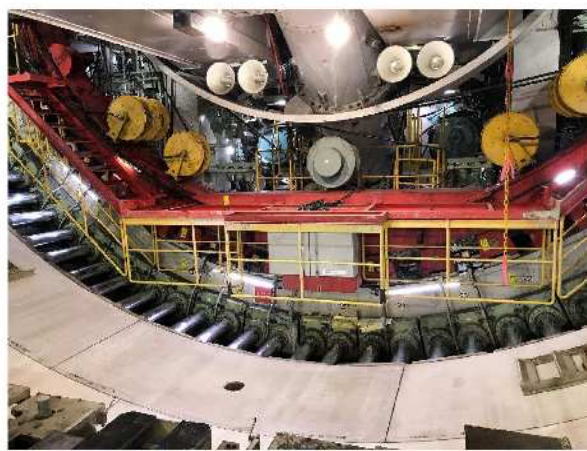
写真2 坑内状況写真(マシン下部)
