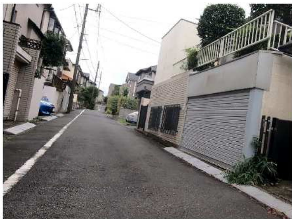
写真1 陥没箇所の事前状況写真(2020年7月30日)
