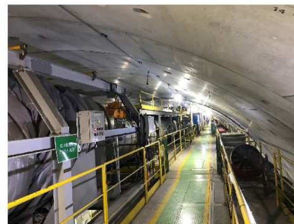
写真3 坑内状況写真(陥没位置付近右側)
