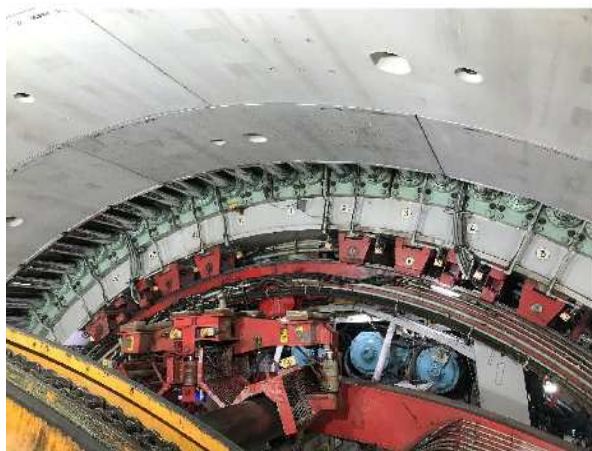
写真1 坑内状況写真(マシン上部)
