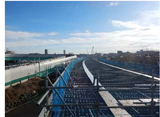
橋梁上部工施工状況(大泉JCT)
