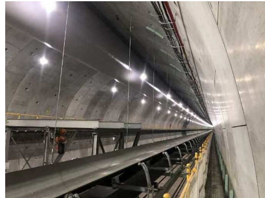
写真5 坑内状況写真(空洞発見箇所付近セグメント状態)
