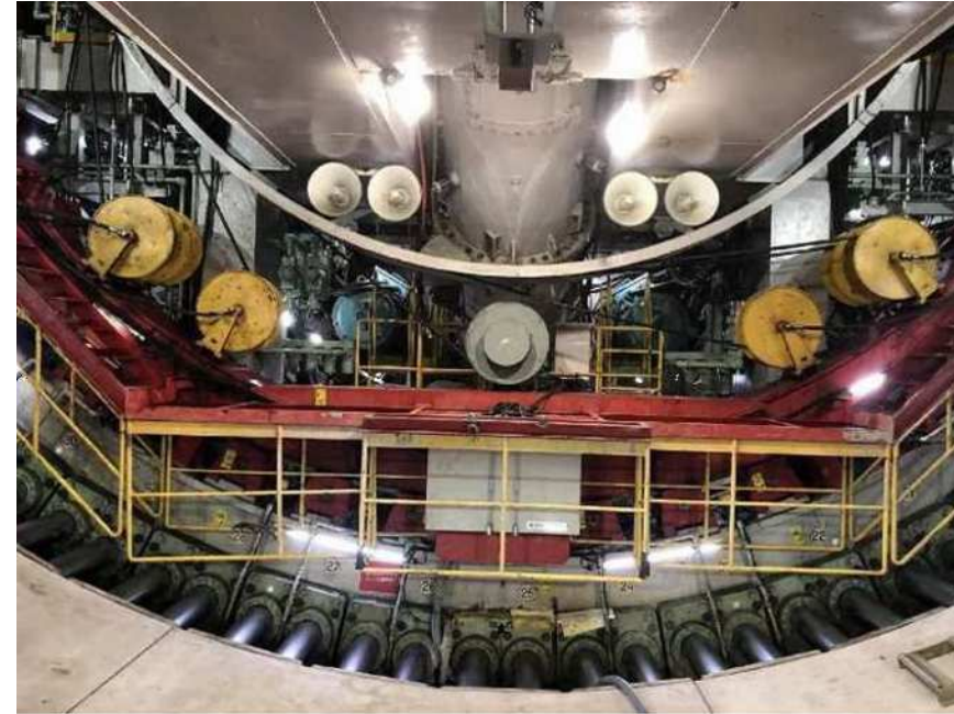
写真2 坑内状況写真(マシン下部)
