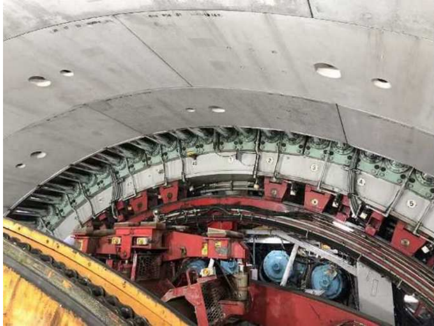
写真1 坑内状況写真(マシン上部)
