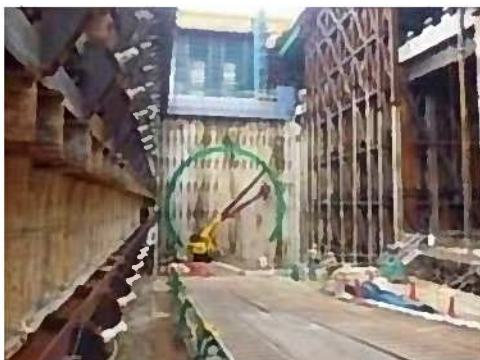
工事の写真(イメージ)
