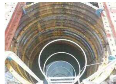
空気を使用しない掘進方法では観測立坑からの漏気はなし
