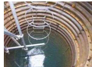
空気を使用する掘進方法(改良気泡)による観測立坑からの漏気
