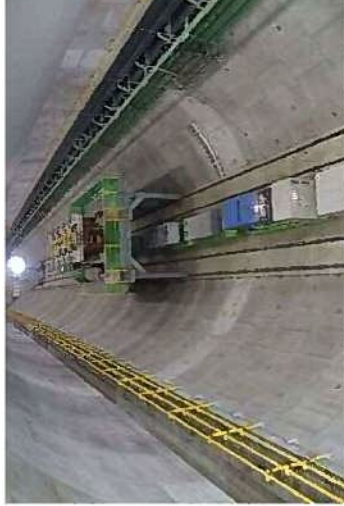
トンネル坑内でセグメントを運搬している状況 (2019年6月10日)
