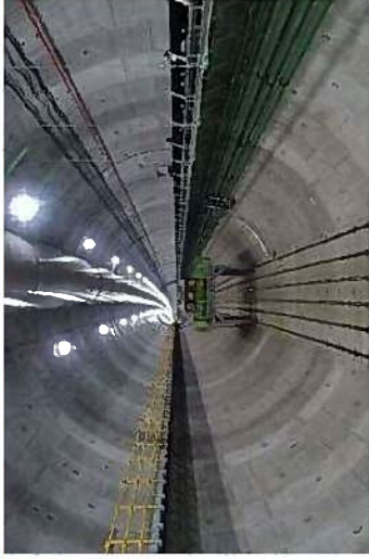
トンネル坑内の状況 (2019年6月18日)
