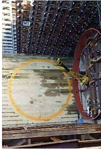
発進立坑内において、シールド機発進坑口用の鋼製リングを組み立てている状況 (2018年1月11日)
