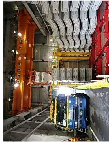
セグメントストックヤードのセグメント搬送状況 (2019年6月10日)
