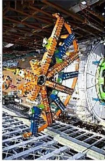
発進立坑内において、シールド機発進坑口用の鋼製リングを組み立てている状況 (2018年1月11日)
