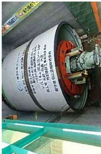
大泉南 開削部のFランプシールド発進立坑部 シールド設置状況(2019年6月5日)
