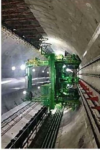
トンネル坑内の内部構築作業の状況 (2019年6月18日)
