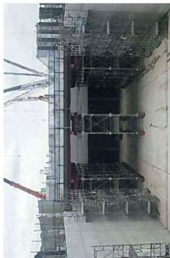
東映通り切り替えに伴う仮橋の設置状況 (2019年6月13日)
