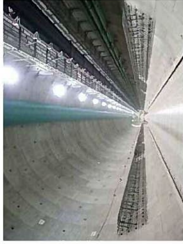
内部構築工・側壁鉄筋組立 (2019年6月19日)
