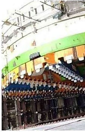
シールド機の駆動部を設置している状況 (2018年5月4日)
