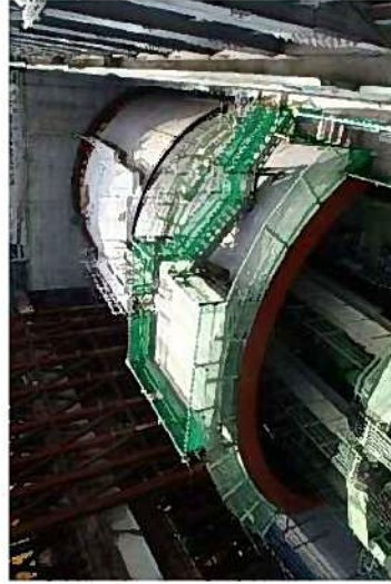
大泉JCT北行シールドマシンの組立状況 (2018年6月22日)
