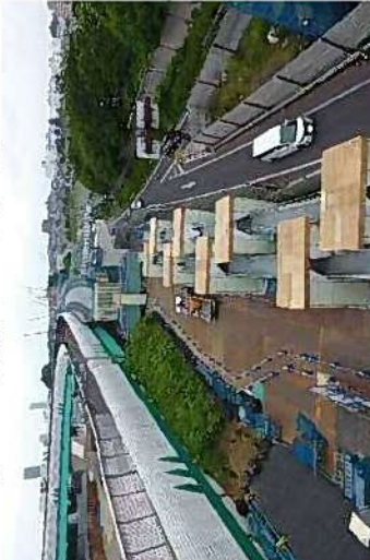
大泉南 開削部 路面工下支持杭の打設を 行っている状況。(2019年5月16日)
