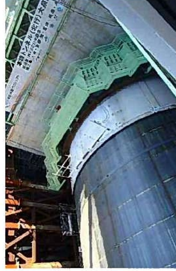
大泉JCT北行シールドマシンの後継台車を組み立てている状況 (2018年9月18日)
