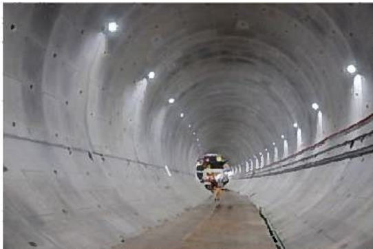
トンネル内部の写真(イメージ)
