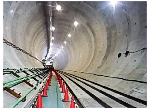
トンネル内部の写真(イメージ)
