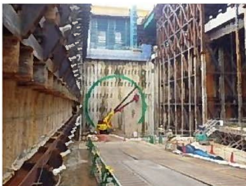
工事の写真(イメージ)
