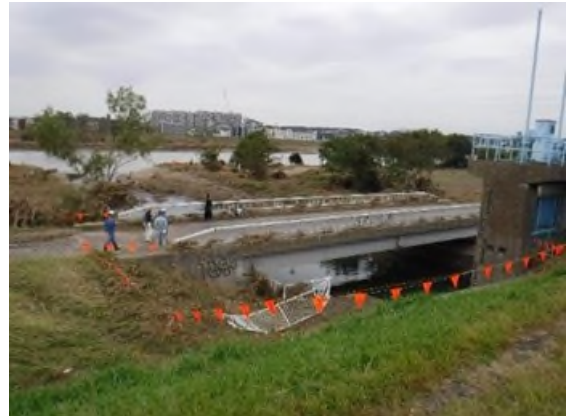
多摩川（調布排水樋管付近）（10月16日(水)15時頃）
