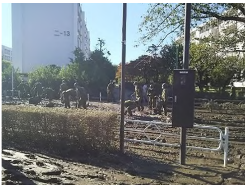
自衛隊による土砂対応（多摩川住宅付近）
