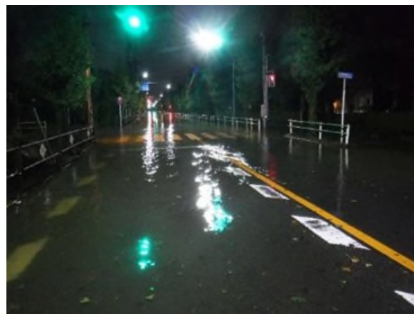
道路の冠水の状況（10月12日（土）23時頃）
