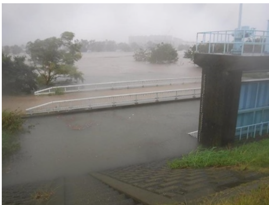
調布排水樋管の状況
