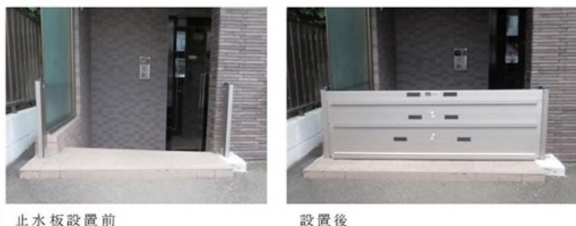
止水板の設置例
