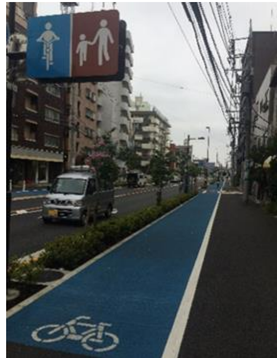
図 5-15 自転車歩行者道（視覚的分離）の整備事例（品川通り・主要市道 12 号線）
