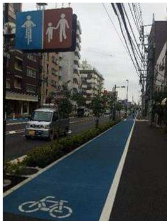
図 5-15 自転車歩行者道（視覚的分離）の整備事例（品川通り・主要市道 12 号線）
