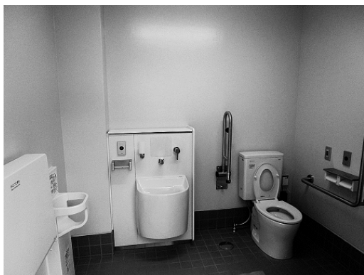
深大寺自然広場内トイレ（改修後）
