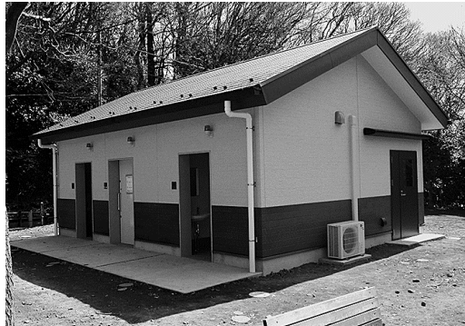
深大寺自然広場内トイレ外観（改修後）
