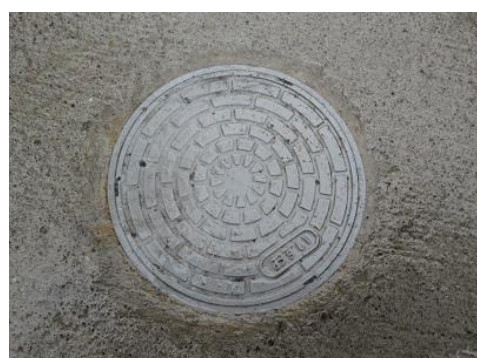
▲汚水柵 (小型のマンホール)
