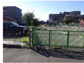
<現況写真>市道南199号線
