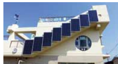
調布市多摩川自然情報館の壁面に設置された太陽光発電パネル
