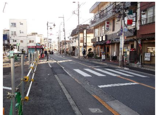
布田南通り沿道
