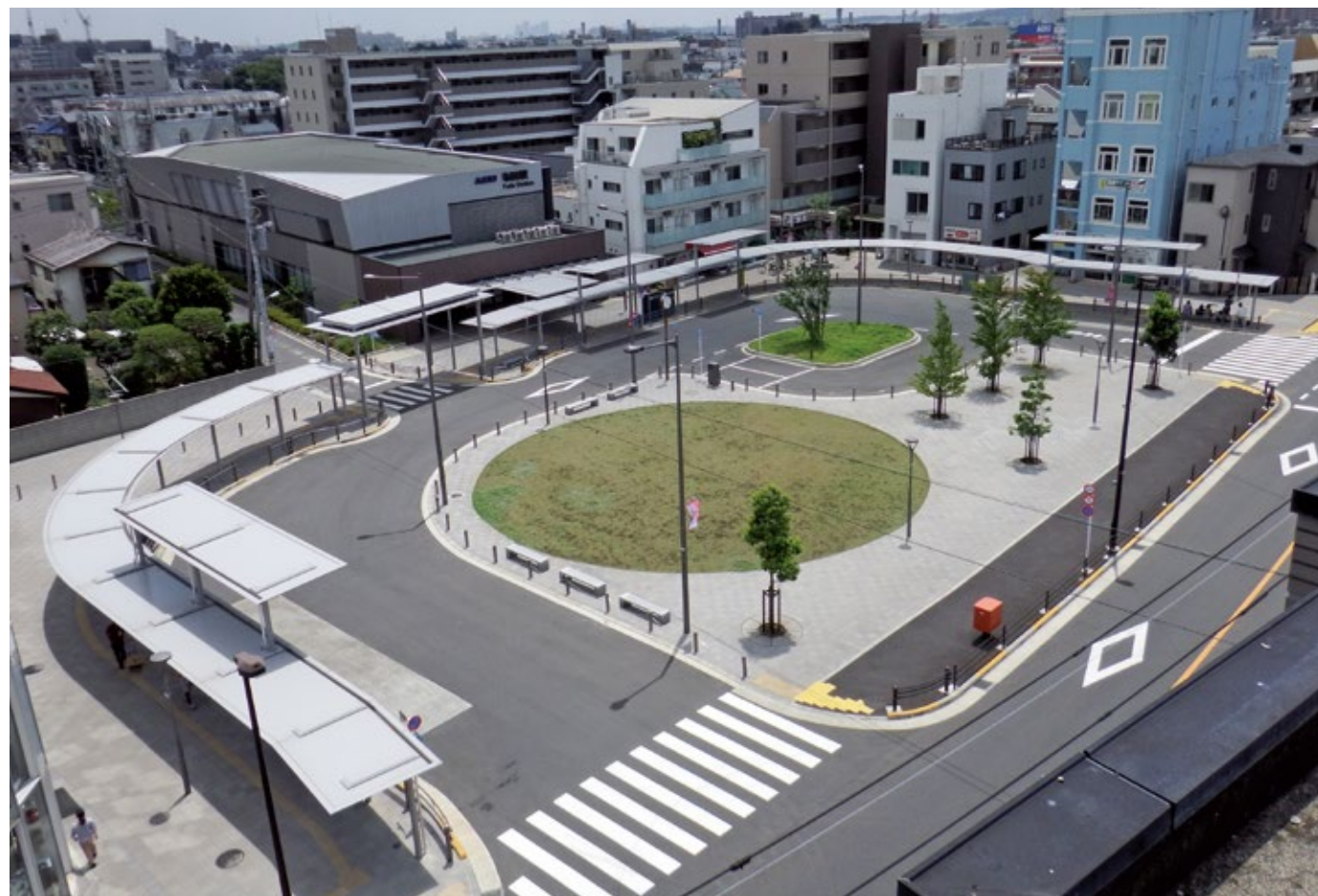
布田駅前広場を北西側から撮影
