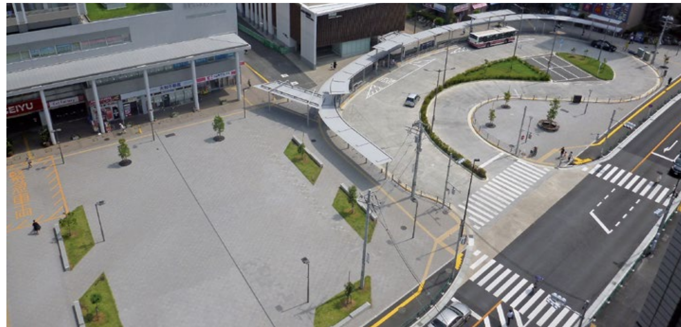
駅前広場を北西側から撮影
