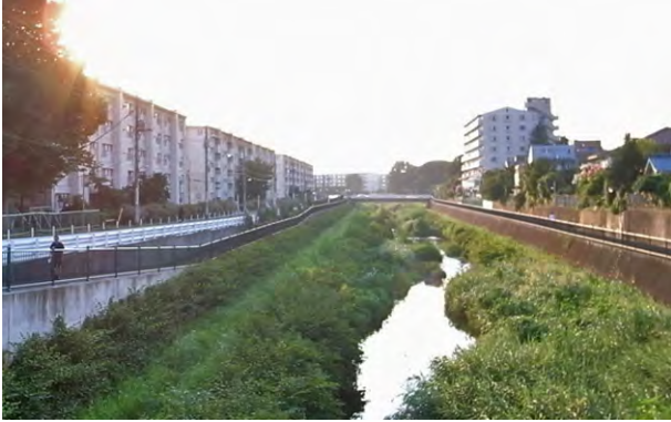
野川大橋から神代団地方面を望む（入間町）
