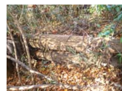
旧土留め柵設置状況
