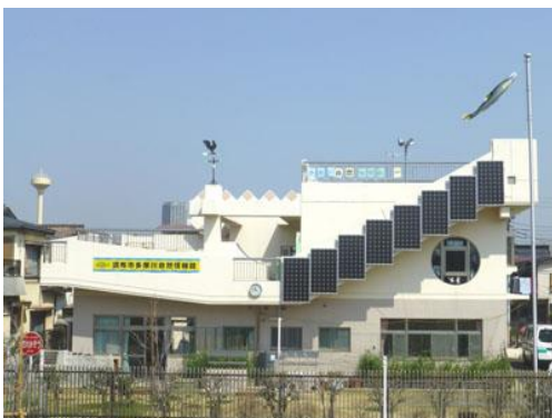
<多摩川自然情報館の太陽光パネル>
