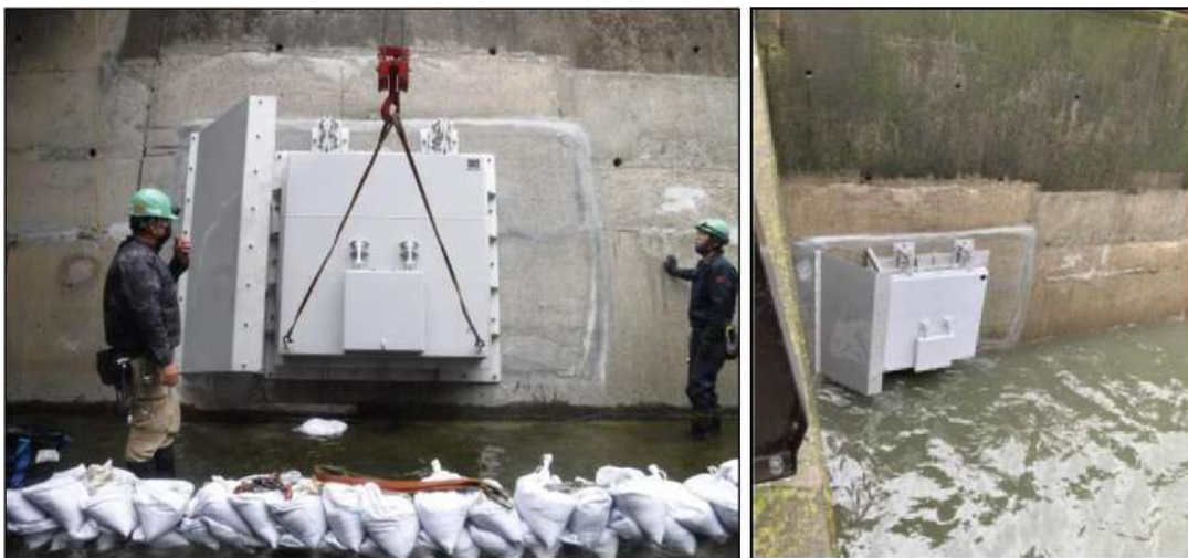
図 3-2-1 逆流防止ゲート設置状況及び設置後
