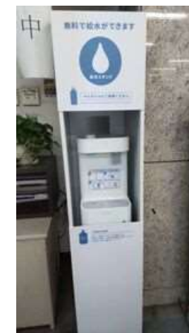
給水スポット (小金井市)
