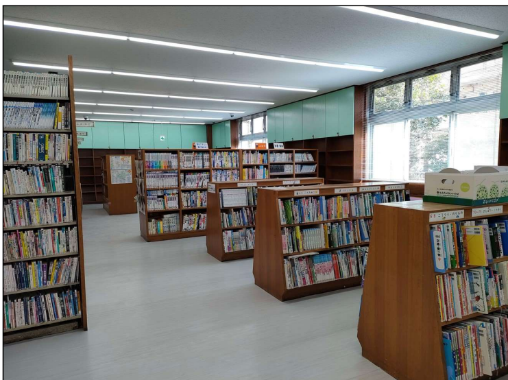
No.6 調布市染地地域福祉センター及び 調布市立図書館染地分館改修工事 図書閲覧室内 施工状況
