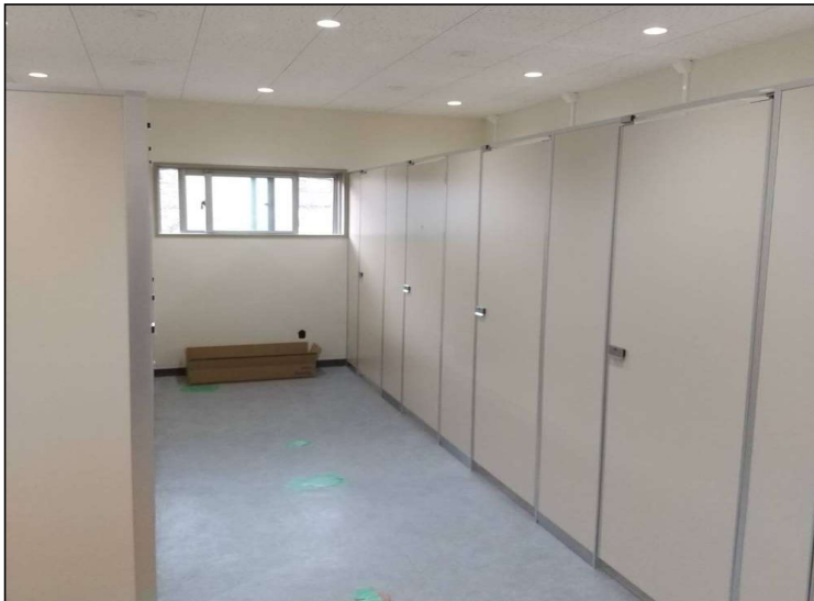
No.5 調布市八ヶ岳少年自然の家機械設備改修工事 トイレ内 施工状況
