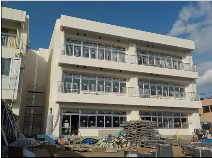
No.4 調布市立布田小学校校舎増築工事 増築校舎 外観
