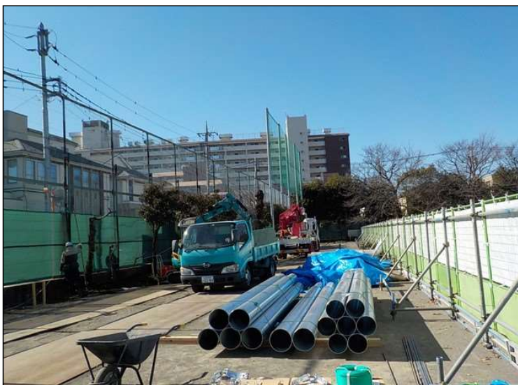
No.3 調布市立第八中学校防球ネット改修工事 仮設工事 施工状況
