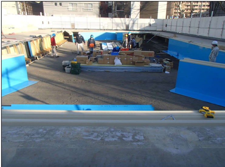
No.2 調布市立八雲台小学校プール水槽ほか改修工事 FRP製プール水槽 施工状況
