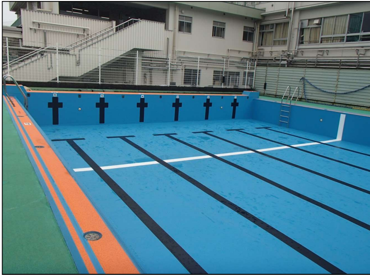
No.1 調布市立第八中学校プール水槽改修工事 防水シート貼 施工完了
