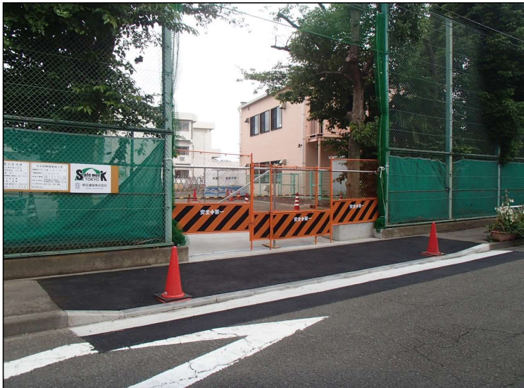
No.2 調布市立布田小学校外構ほか工事 歩道切下げ工事 施工状況
