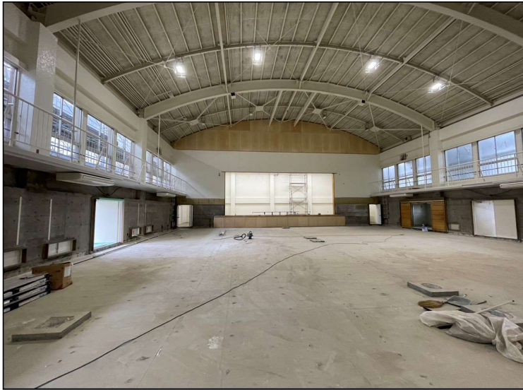
No.1 調布市立第一小学校体育館改修工事 体育館内部 施工状況
