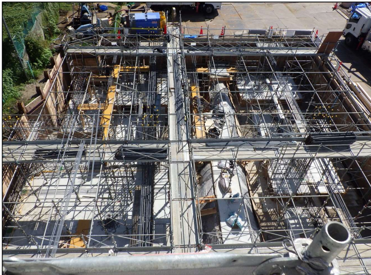
No.5 調布市立布田小学校校舎増築工事 基礎工事 施工状況
