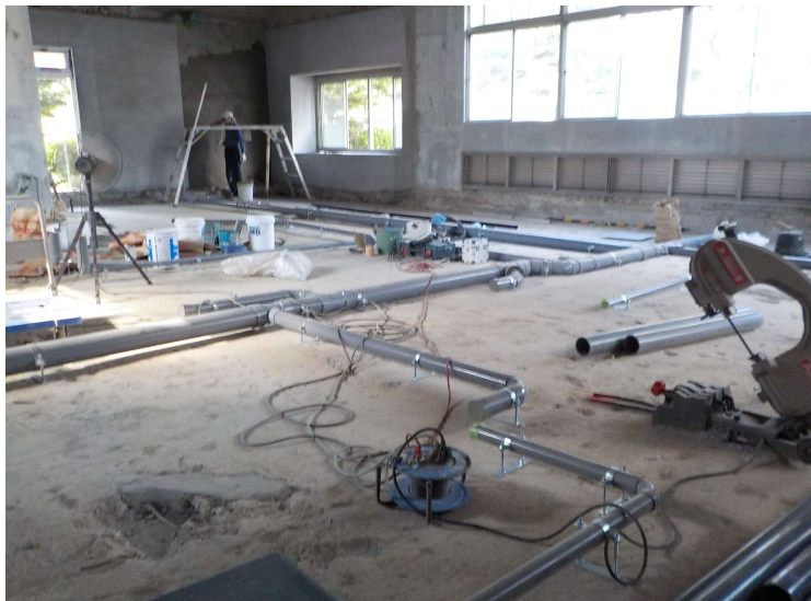
No.2 調布市立国領小学校給食室ほか改修工事 設備配管 施工状況
