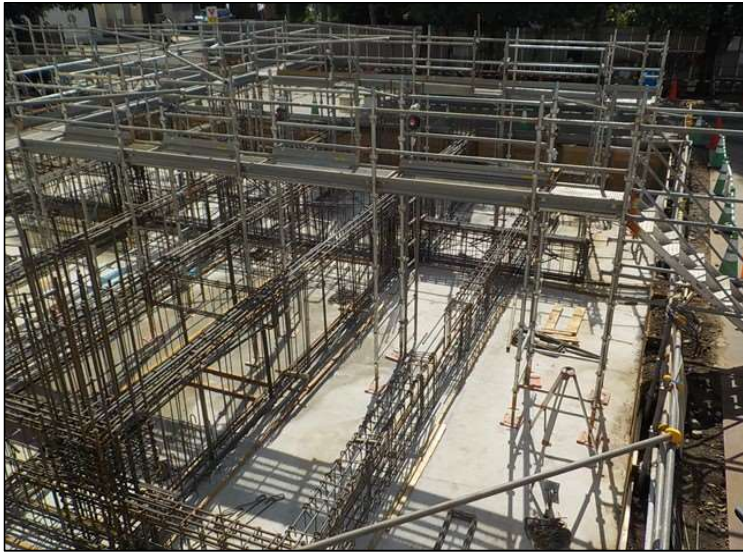
No.4 調布市立多摩川小学校校舎増築工事 基礎工事 施工状況
