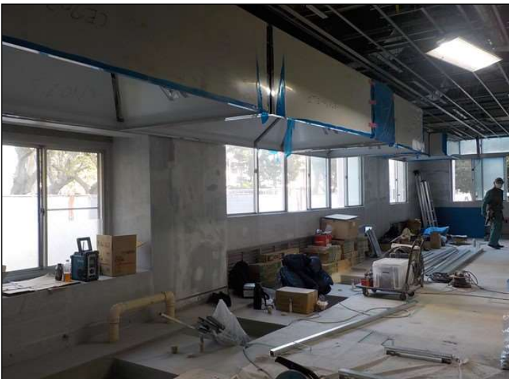
No.2 調布市立国領小学校給食室ほか改修工事 調理室内 施工状況
