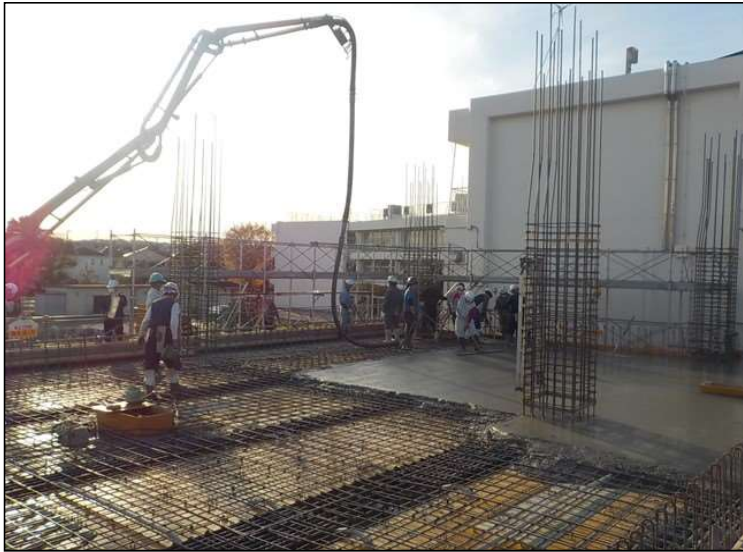
No.4 調布市立布田小学校校舎増築工事 1階躯体工事 施工状況
