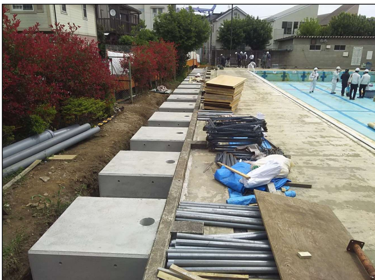
No.3 調布市立柏野小学校プール水槽ほか改修工事 フェンス基礎 施工状況
