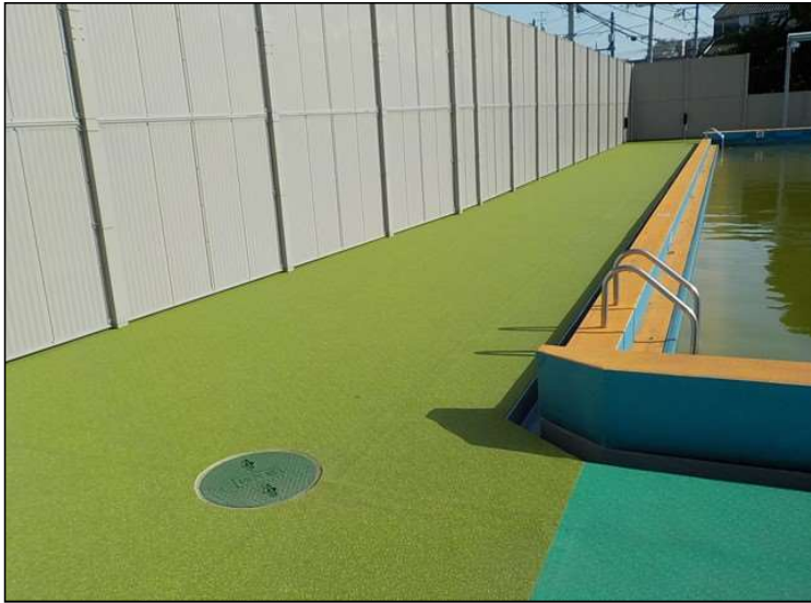
No.1 調布市立飛田給小学校 プール甲羅干し廻り改修工事 工事完了
