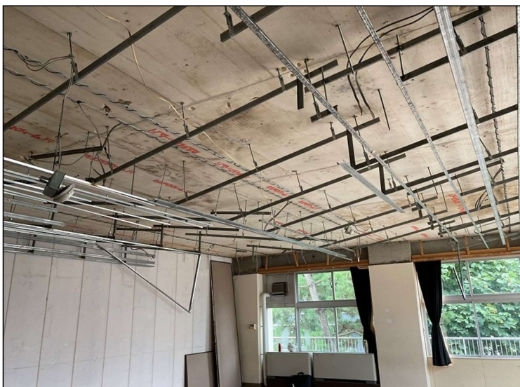
No.6 調布市立滝坂小学校普通教室整備工事 視聴覚室 内装材撤去状況
