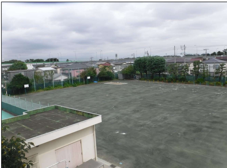
No.6 調布市立石原小学校校庭整備工事 校庭 施工状況
