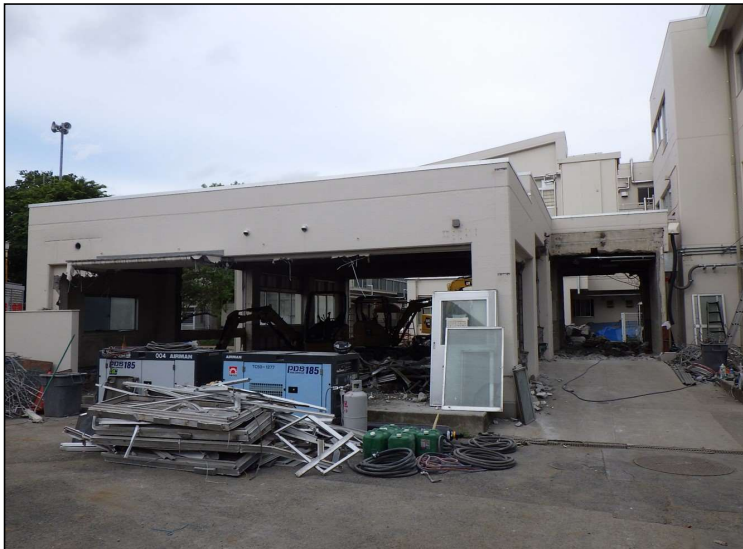
No.5 調布市立柏野小学校給食室改修工事 解体作業 施工状況
