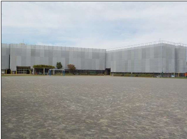
No.2 調布市立布田小学校校舎外壁改修工事 仮設足場 設置状況
